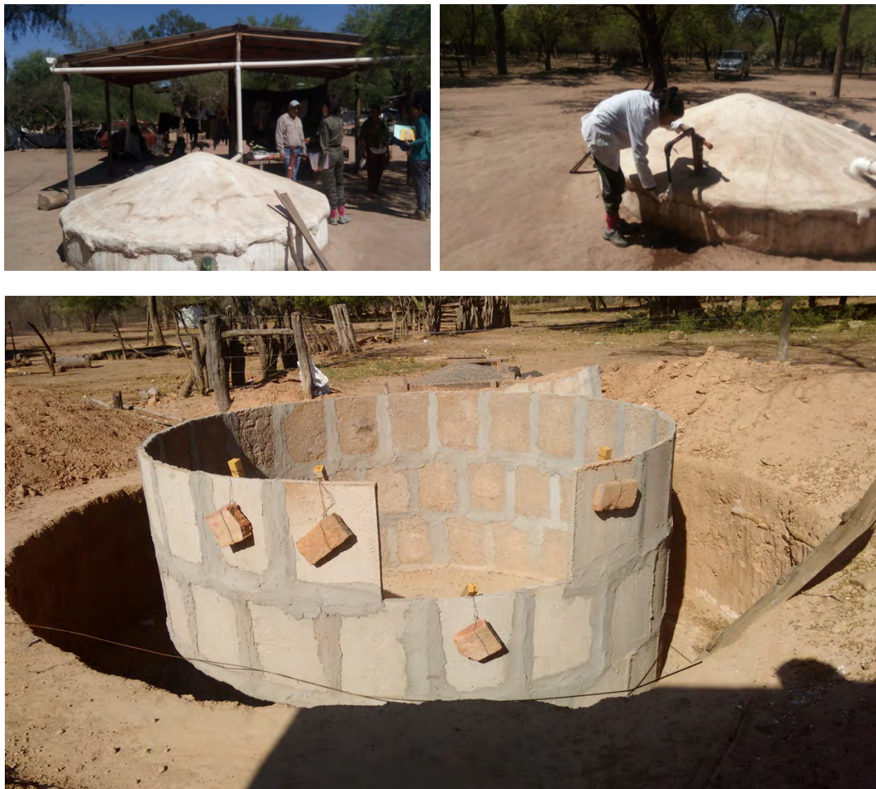
Figura 67. Sistema de cosecha de agua. Arriba: cisterna de placas de 16000 litros. Abajo: cisterna en construcción.
