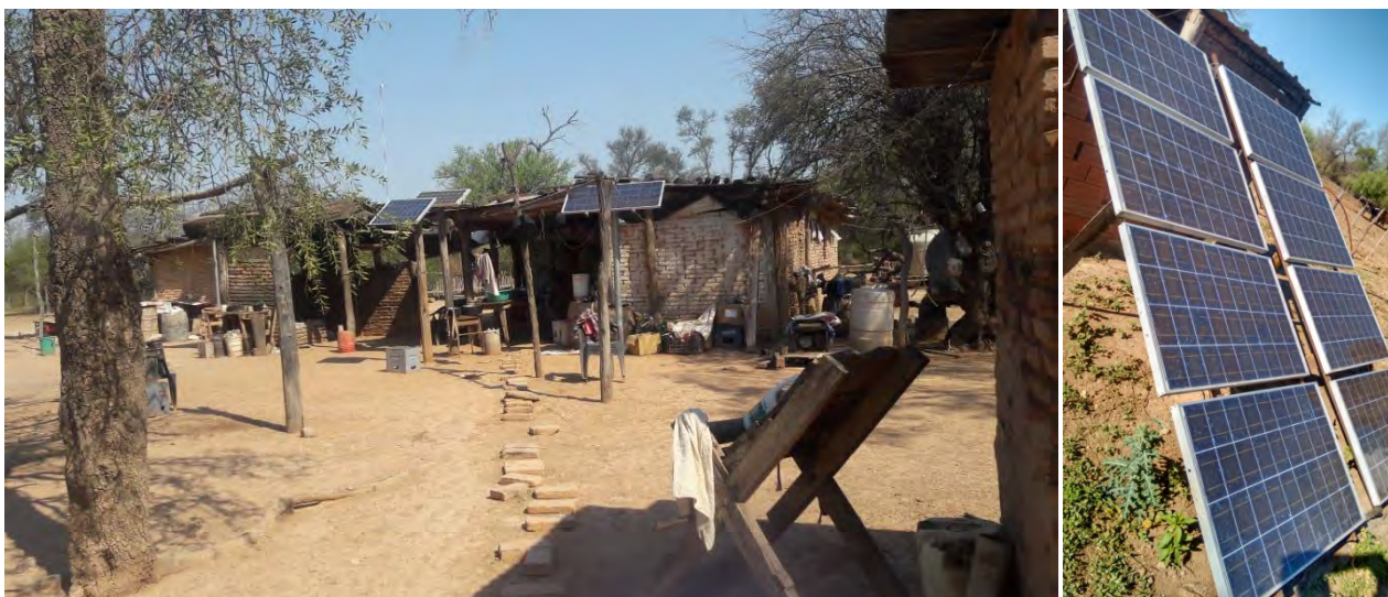
Figura 64. Paneles solares para generación de energía eléctrica comunes a todos los puestos.
